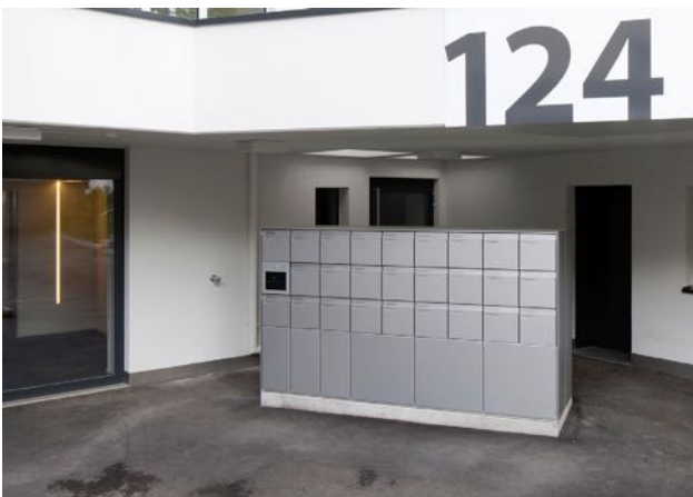
Abb. 31: Freistehende Paketbox - MFH
